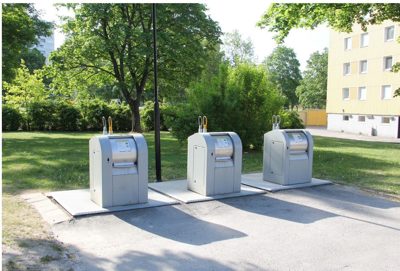
Figur 5 Bottentömmande behållare under jord.
